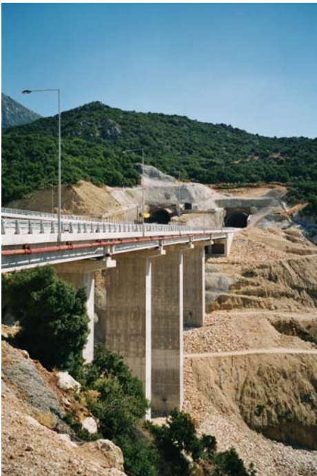
Egnatia Odos SA Motorway, Greece
